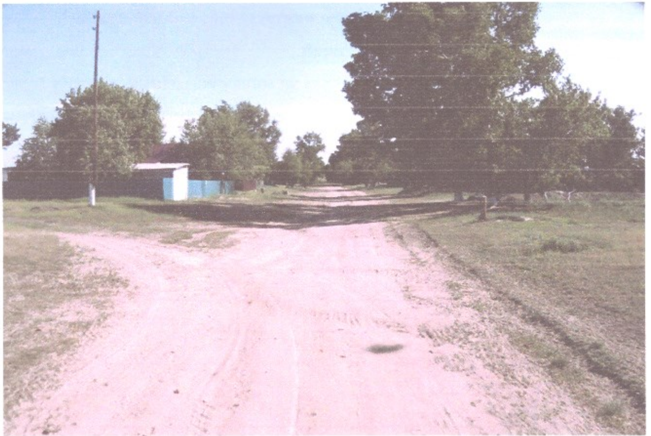
Рисунок 3.1.7 – Состояние покрытия на участке ПК 1+080
