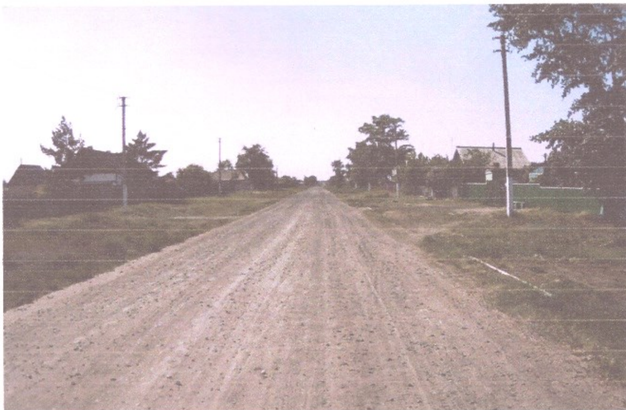
Рисунок 2.1.4 – Состояние покрытия на участке ПК 0+250
