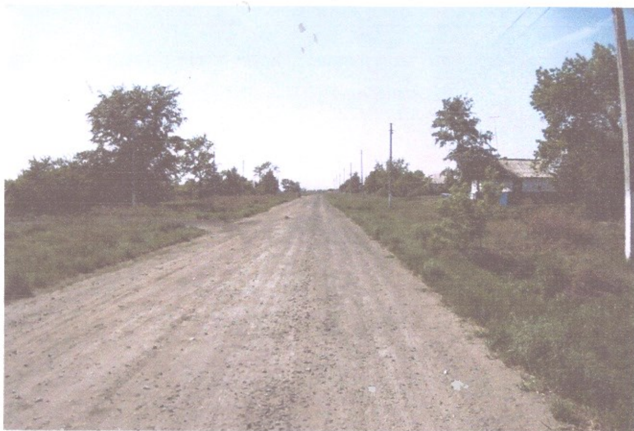
Рисунок 2.1.7 – Состояние покрытия на участке ПК 1+250
