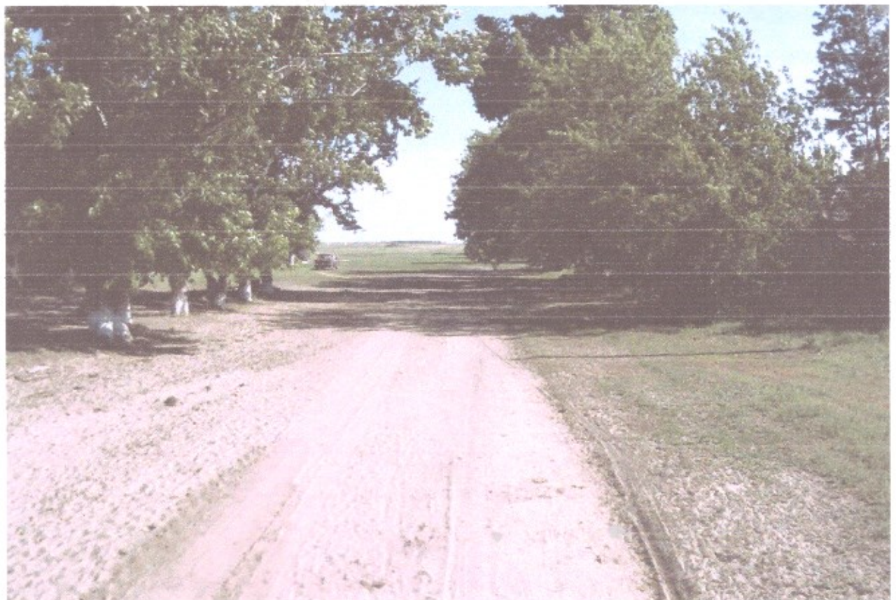
Рисунок 3.1.8 – Состояние покрытия на участке ПК 1+300
