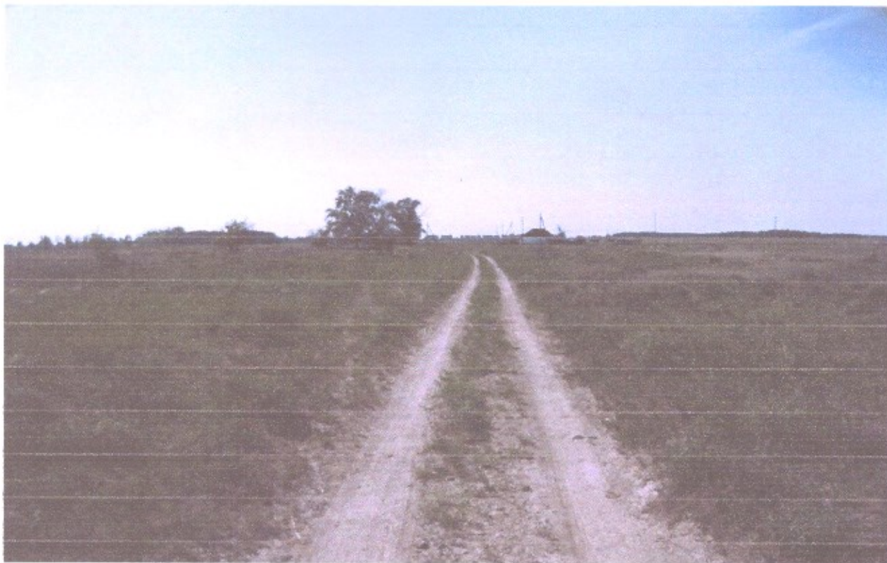
Рисунок 2.1.8 – Состояние покрытия на участке ПК 1+750
