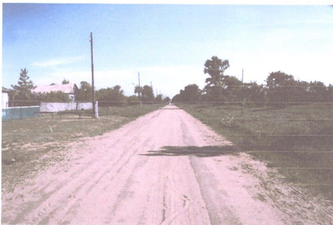
Рисунок 3.1.4 – Состояние покрытия на участке ПК 0+250
